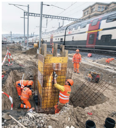
Herausforderung: Bauen unter laufendem Betrieb. (Bild: © SBB CFF FFS)
